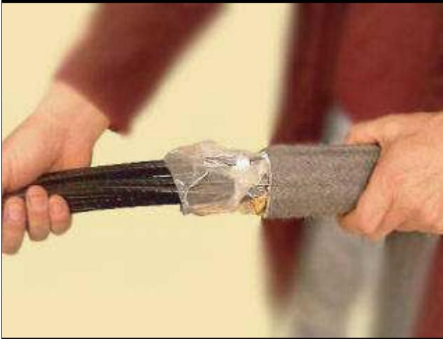
● 将新管束固定在一起时要注意，小心不要用力将其压到动力单元上，并插入护套，将其滑到尼龙袋上。
